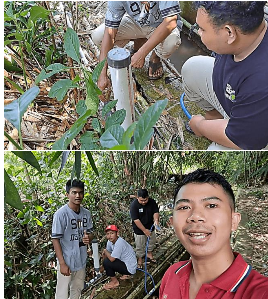
Gambar 5. instalasi pompa hidram
