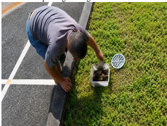
Gambar 3: Proses Pemasangan Lubang Biopori Proses Pemanfaatan [3]
