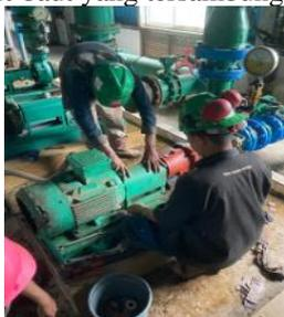
Gambar 14 Breakdown Perbaikan Feed Pump
