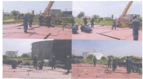
Gambar 6. Proses penyusunan Bottom & Annular
