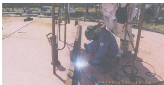
Gambar 8. Proses pengelasan bottom
