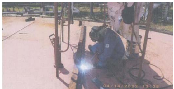
Gambar 8. Proses pengelasan bottom
