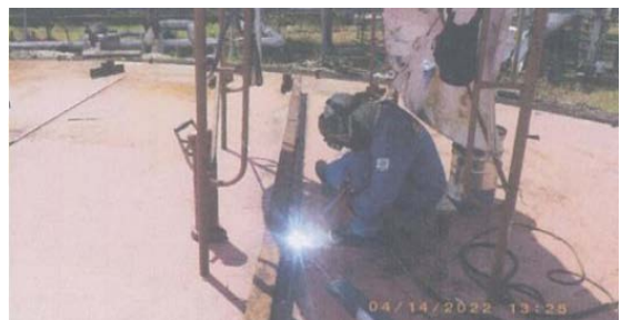
Gambar 8. Proses pengelasan bottom
