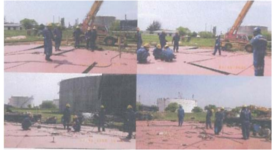
Gambar 6. Proses penyusunan Bottom & Annular
