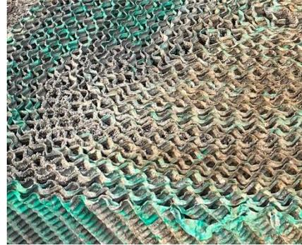
Gambar 2. Kondisi aktual pengotor yang terbentuk pada filler
